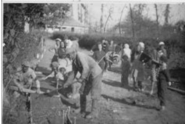
1960. Járdaépítés társadalmi munkában, a Jegenyesoron (forrás: Orosz Tiborné)
